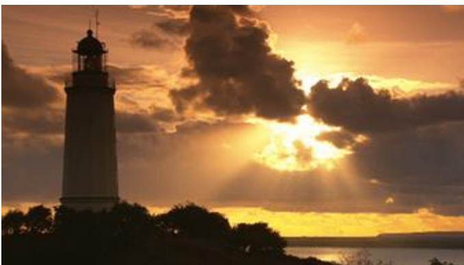
Der Hiddenseer Leuchtturm ist das Wahrzeichen der Insel
